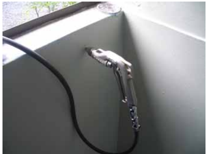
お風呂場薬剤注入
