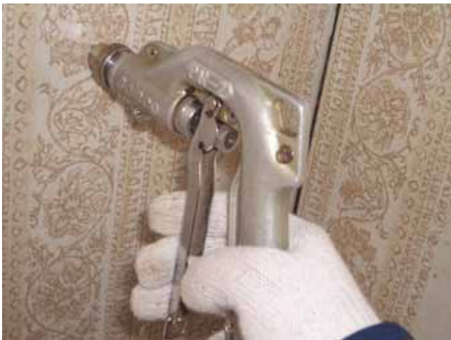
玄関薬剤注入
